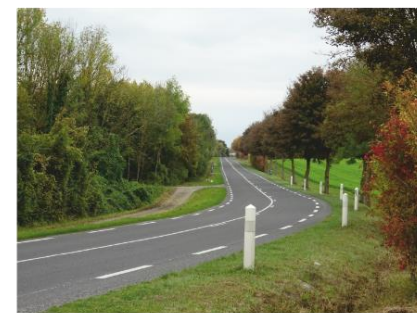
8 - Route départementale RD5
