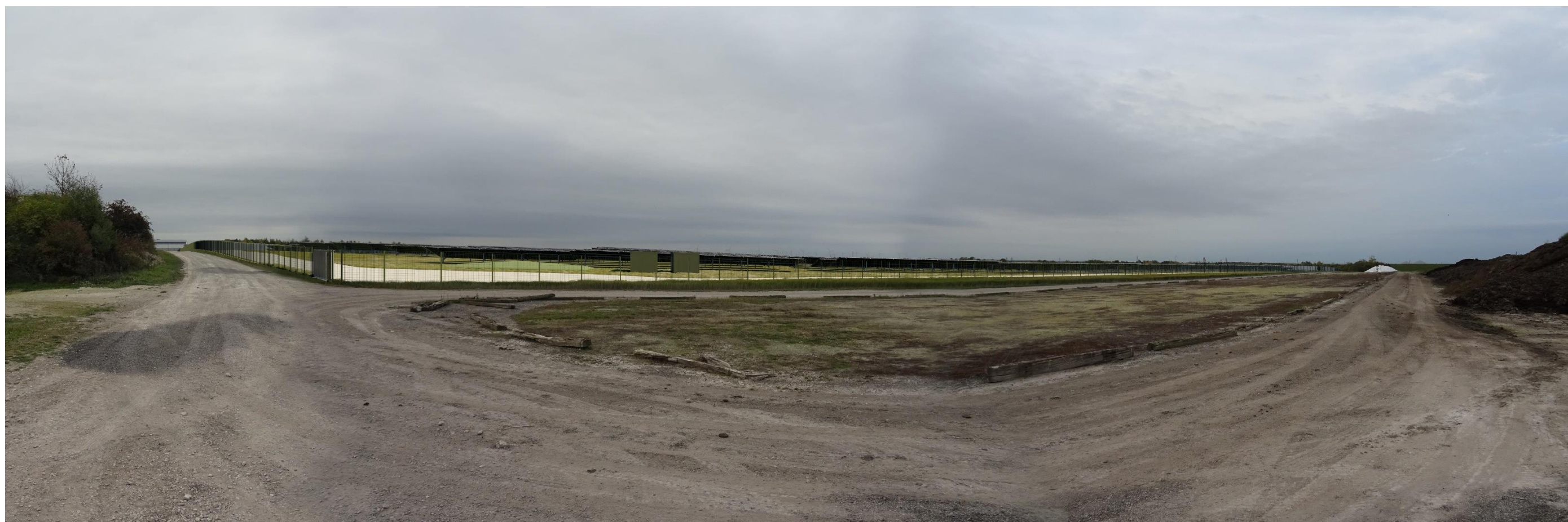
Illustration 34 : Vue depuis le portail nord-est de l'aire d'étude (après projet)
