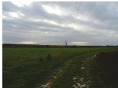
2 - Ligne électrique aérienne
