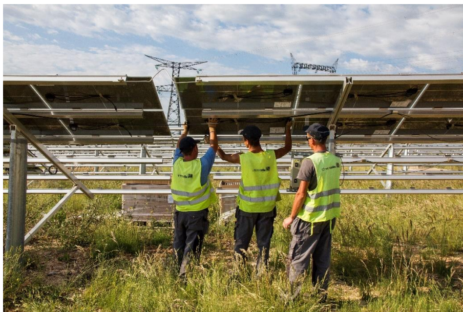
Illustration 25 : Pose de modules (Source : NEOEN)
