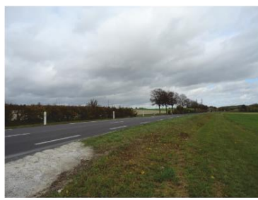
18 - Infrastructures : Route départementale D5
